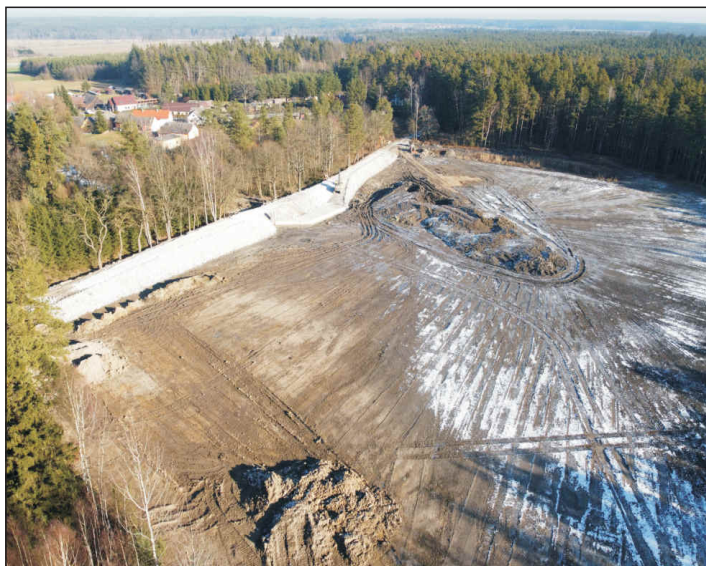
Revitalizace - pohled z dronu - prosinec 2019
