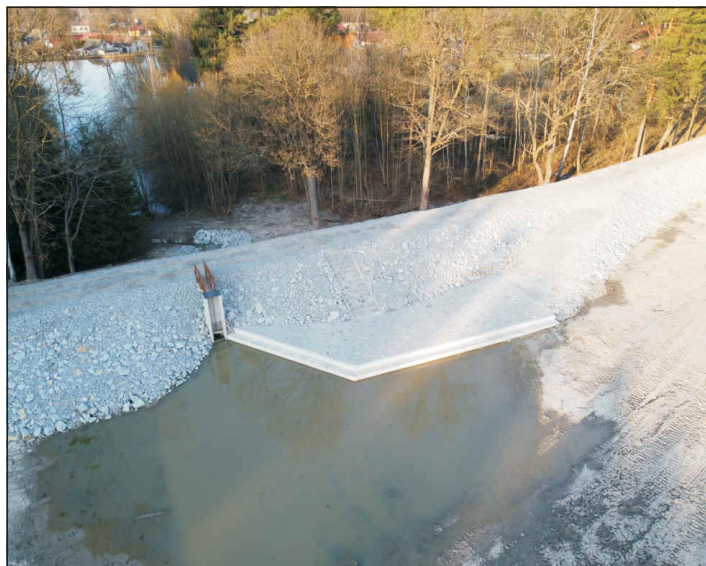
Revitalizace ukončena - pohled z dronu - březen 2020
